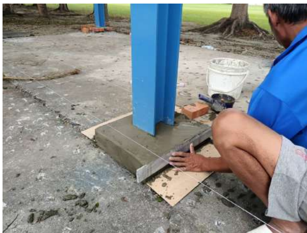
H鋼架底座施作
