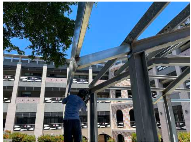
原鋼架屋頂延伸焊接
