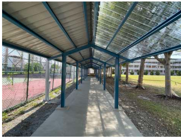
屋頂及地坪施作完成
