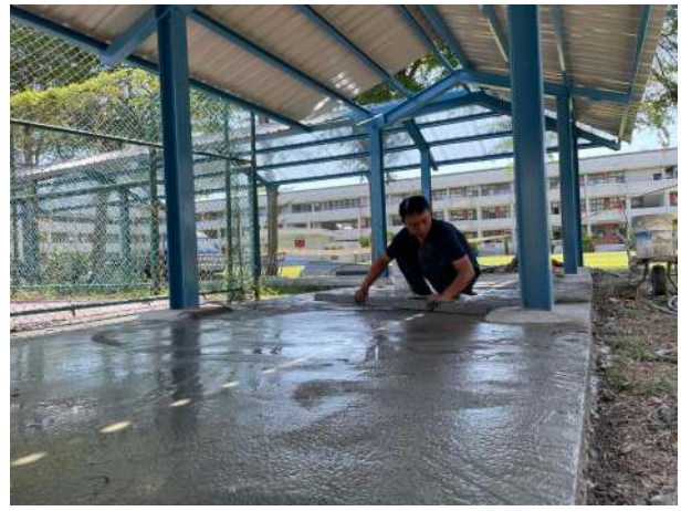
水泥地坪施作
