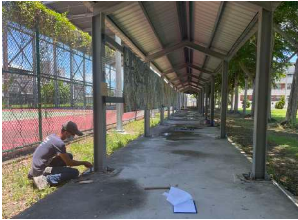
假設工程：水平測量、放樣
