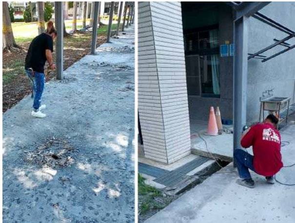
地坪打毛 + 原鋼架除鏽打磨
