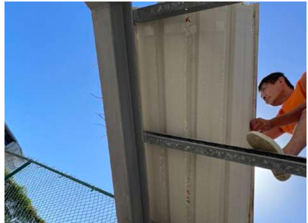
舊鐵皮屋頂拆除
