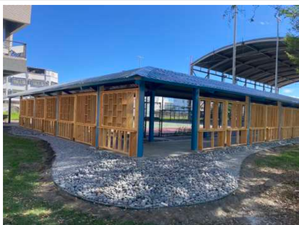
施工後 | 延伸屋簷長度，地坪以石材做介面
