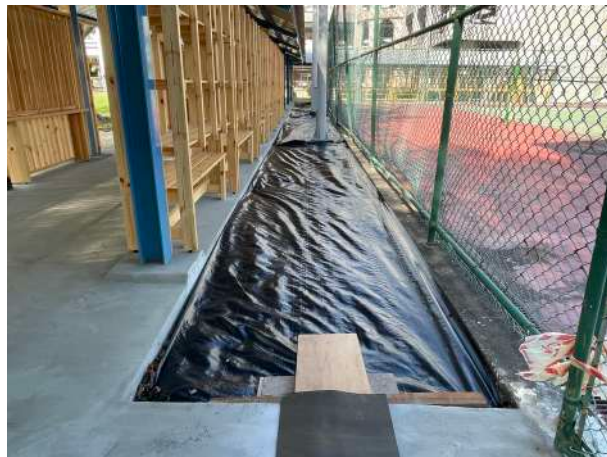
周圍碎石鋪面施作
