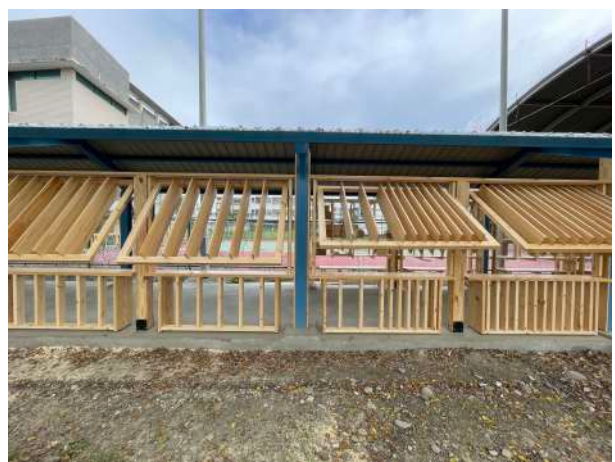
木格柵裝設完工
