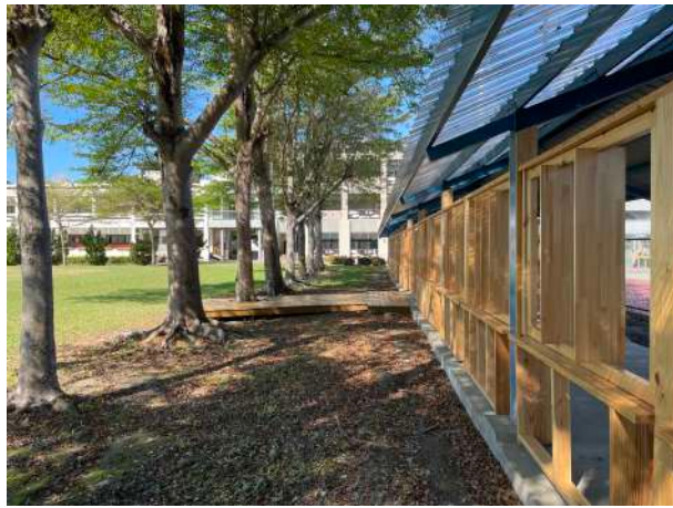
施工後 | 增設平台，將空間與自然串連
