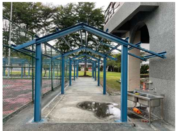
鋼架烤漆 + 地坪整平
