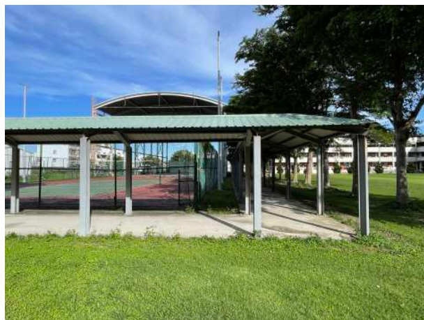
施工前 | 廊道太熱
