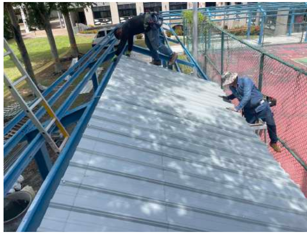
鐵皮屋頂更換
