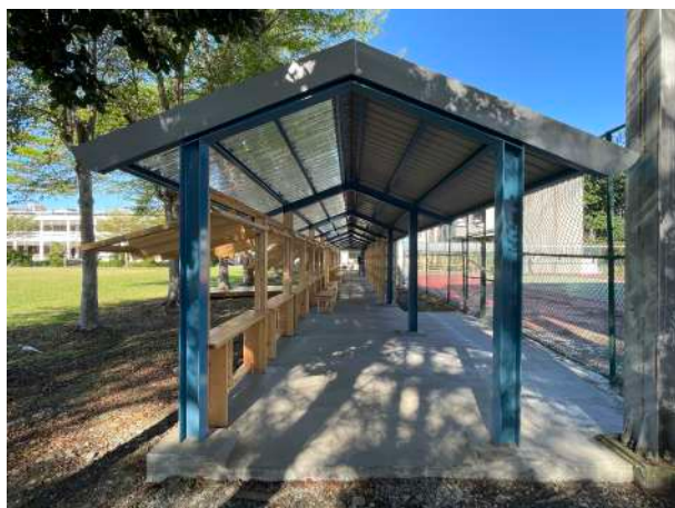
施工後 | 水泥地坪整平後
