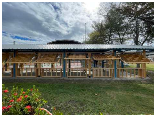
施工後 | 木格柵增加了廊道使用功能
