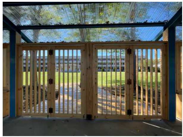
施工後 | 增設平臺，延伸廊道，讓空間與環境更具互動
